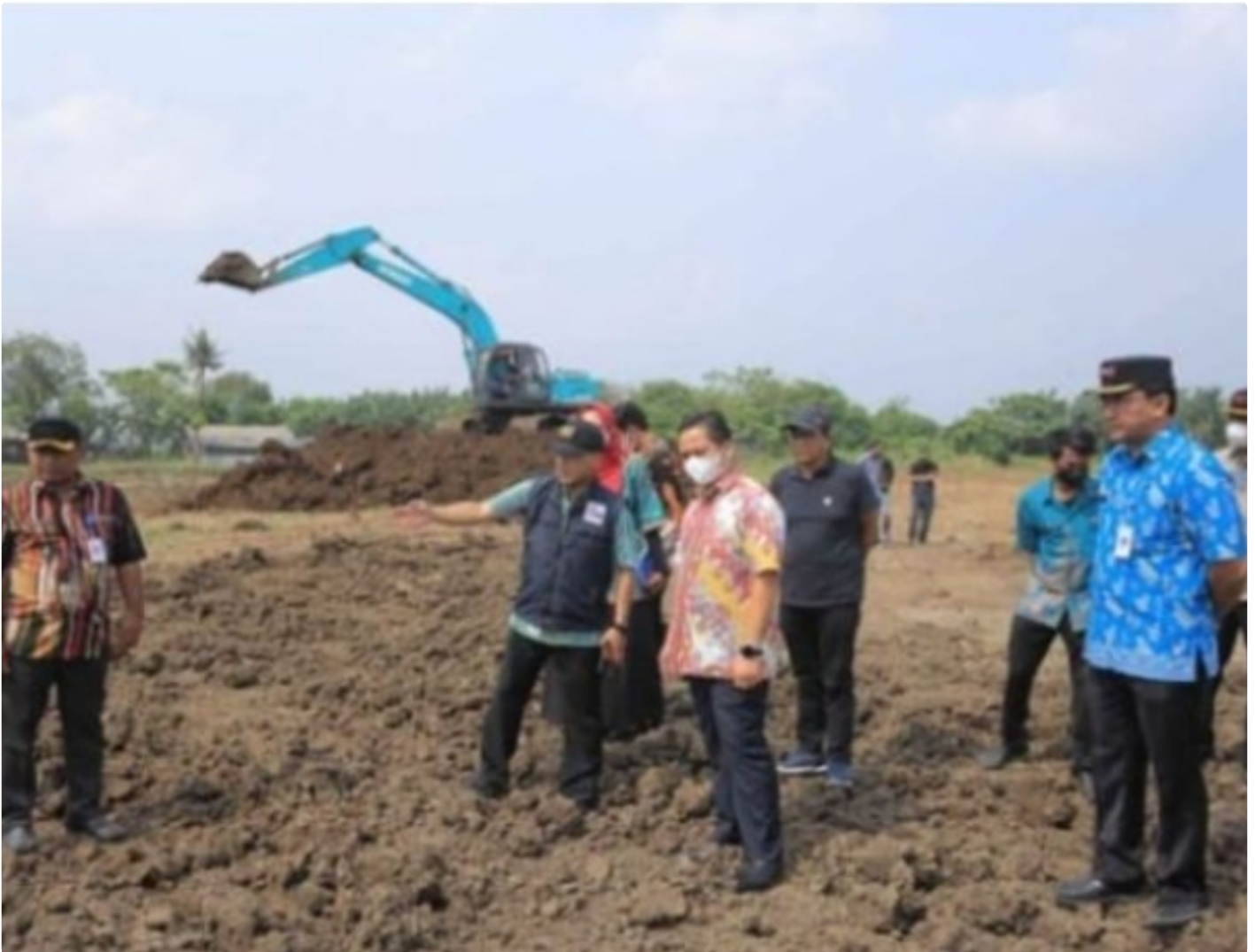
Wali Kota Tangerang Arief R Wismansyah, meninjau pembangunan venue arena Grasstrack
